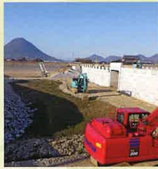
③コンクリートパネル(土壁工事) (左側は池面)
